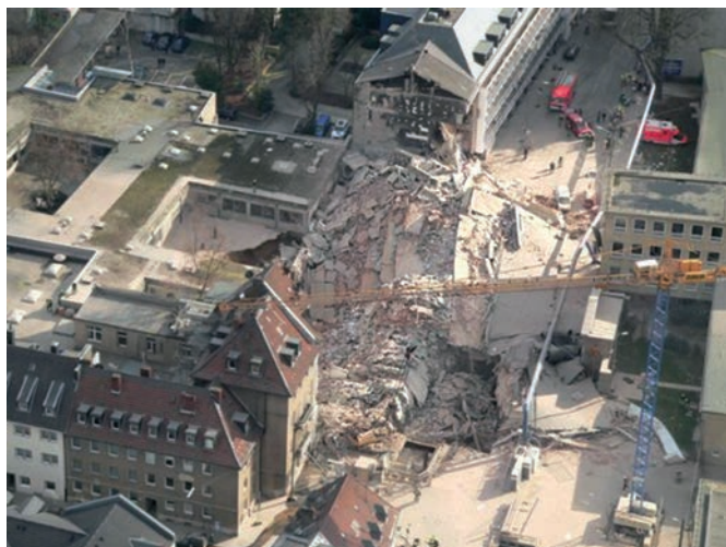
Bild 1 Luftaufnahme der Einsturzstelle an der Baugrube Waidmarkt Köln Aerial view of the collapsed Waidmarkt Pit, Cologne
